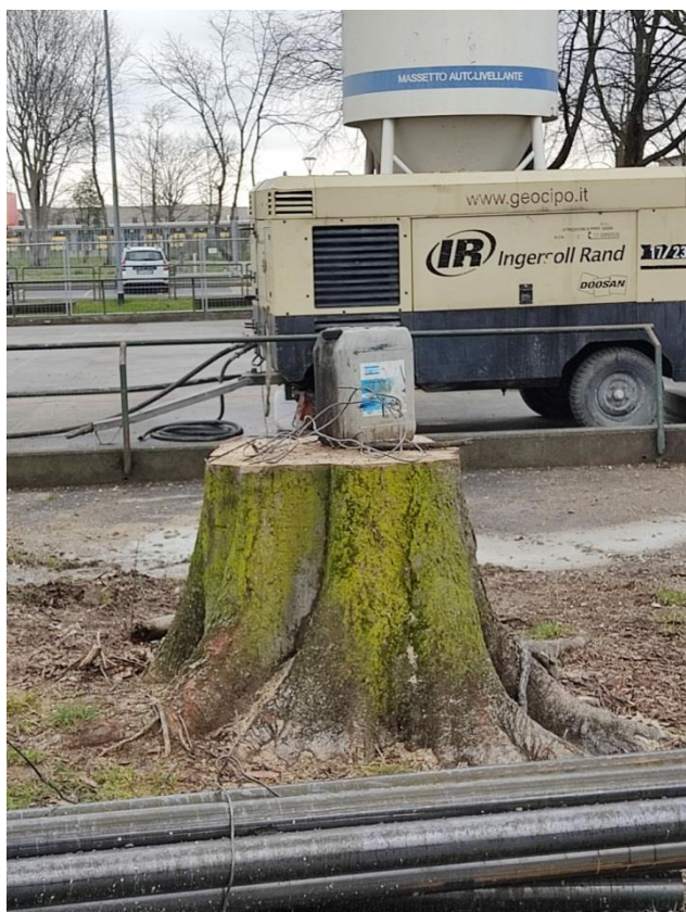
SITUAZIONE AD OGGI 25.02.2024
